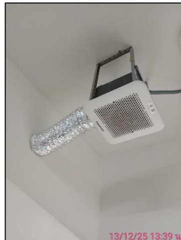
รูปภาพที่ 2.19 พัดลมดูดอากาศ
