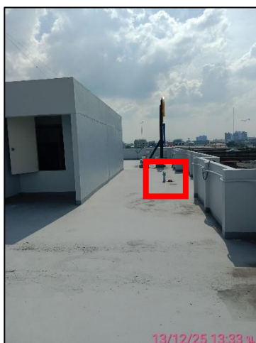
รูปภาพที่ 2.51 ท่อระบายก๊าซมีเทนจากบ่อเกรอะ
